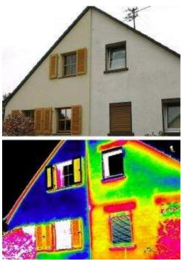
Bildunterschrift: "Thermografie: Der Wärmeverlust bei der linken Haushälfte (mit Dämmung) beträgt nur einen Bruchteil des Verlusts auf der rechten Seite (gelbe und rote Flächen verraten den Wärmedurchgang)." aus: houseandmore.de, abgedruckt in "Bauen & Wohnen", 26.10.06, Verlagsbeilage der Neuen Presse Coburg, Bildquelle: Sto AG, <a href="https://www.pr-nord.de/stoo\_text155.html">www.pr-nord.de/stoo\_text155.html</a>.
